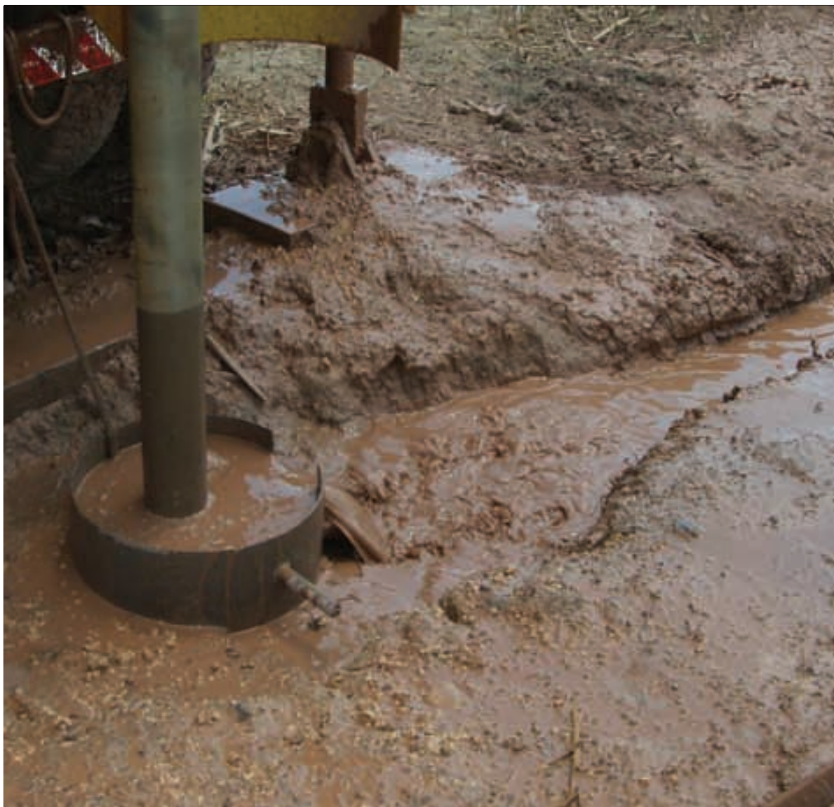
Perfuração de poço em andamento.
