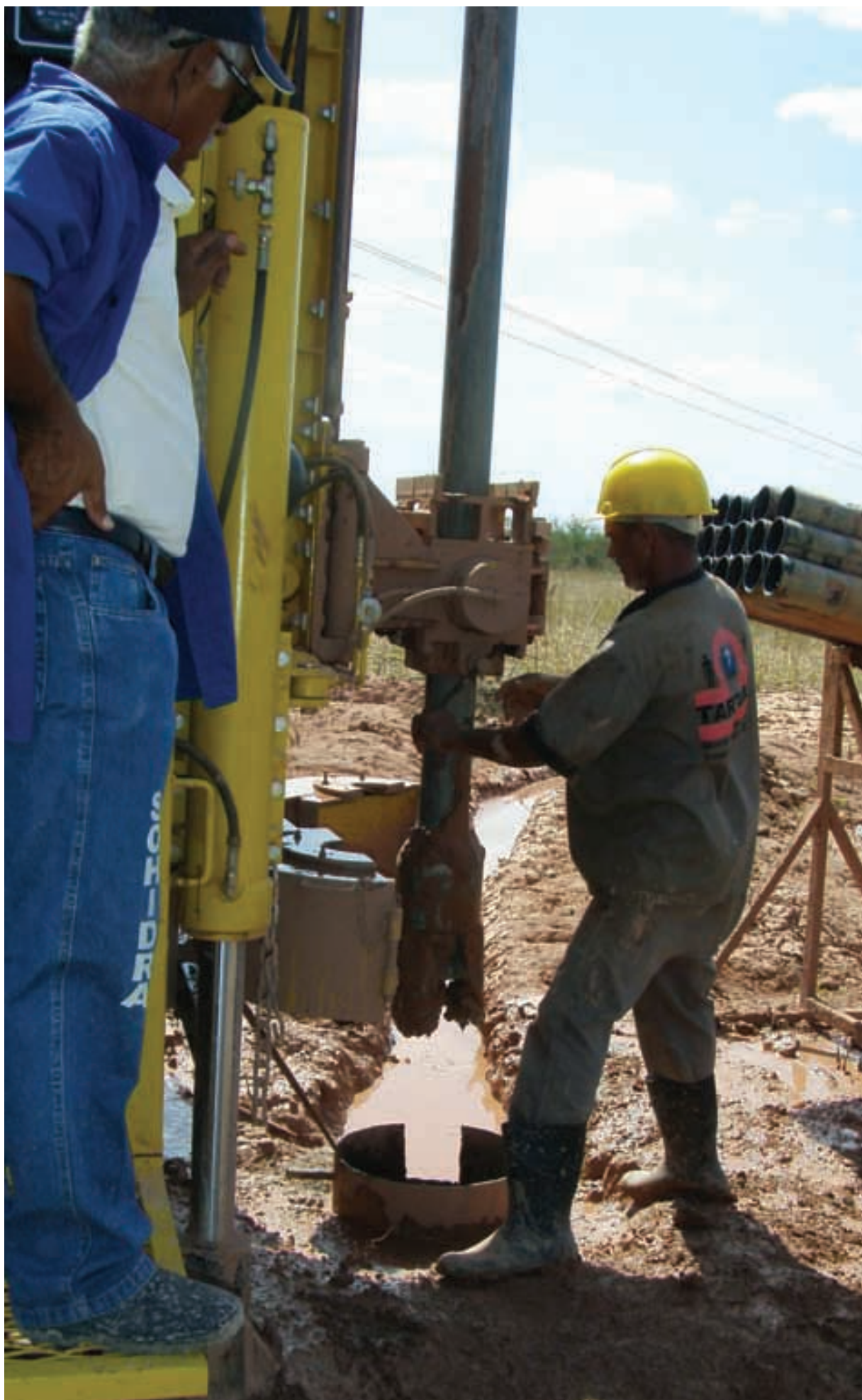
Processo de perfuração de poço profundo
